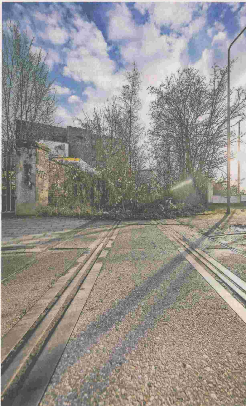
Über diese alte Bahntrasse, die die Straße Am Trippelsberg quert, soll die geplante Verkehrserschließung für das Containerterminal laufen. FOTO: ANNE ORTHEN
